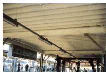
折半屋根内側
